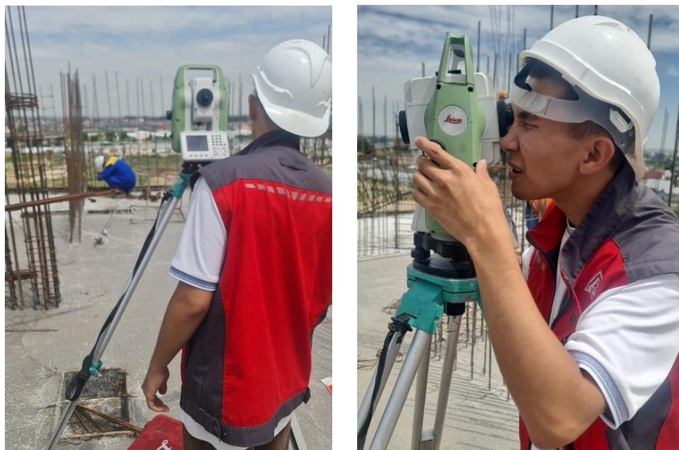
Рисунок 15- Выполнение разбивки осей
